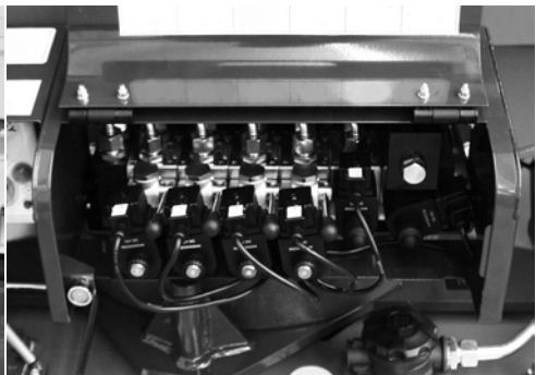
Fig. 68 Hydrauliksteuerungen am Boden
